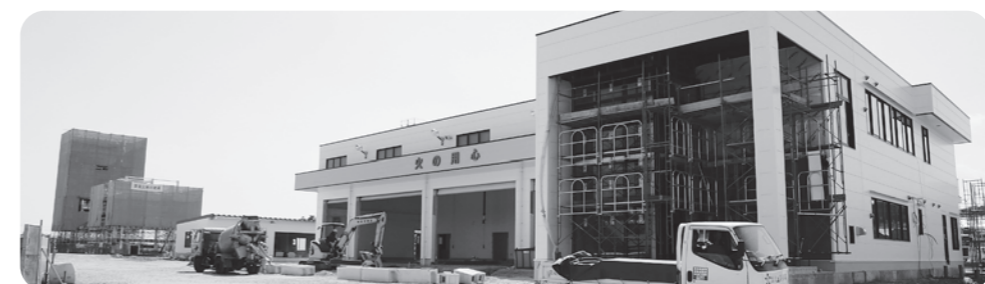
新築工事が進む消防本署。右が消防車両の車庫を兼ねた2階建て本部庁舎、左奥は2つの訓練塔。(国東町北江・3月下旬撮影)
