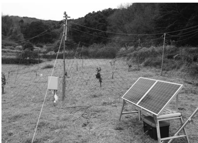
国見町櫛海地区に設置されたドロップネット
