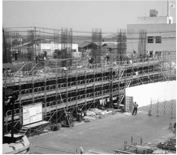
建設中の市役所新庁舎(4月14日撮影)
