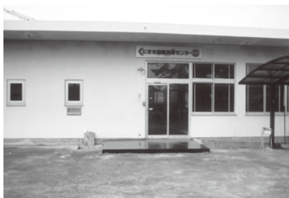
空き家になった産業創出機構の事務所
