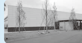
▲平成27年8月に建設した第6工場
